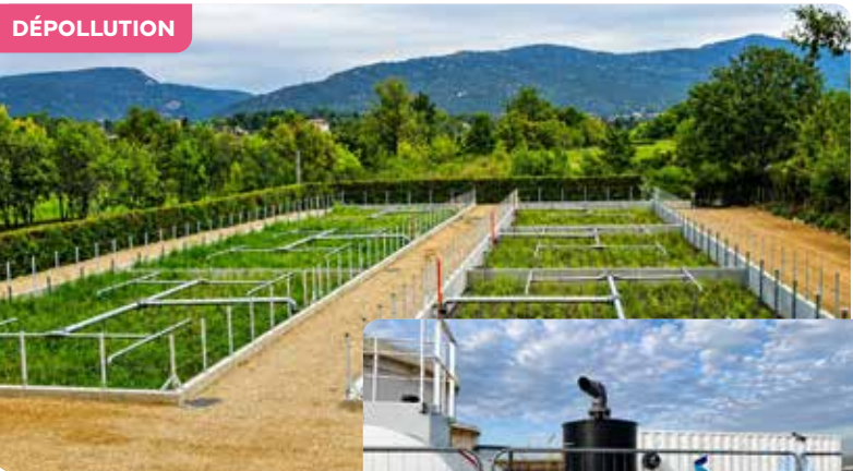
Noisy-Rudignon (77) - Premier marché de traitement des eaux décroché par SERPOL en Île-de-France.
