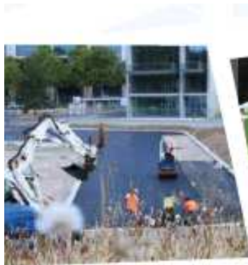
1999 Développement des activités liées aux infrastructures : route, ouvrages d'art, etc.
