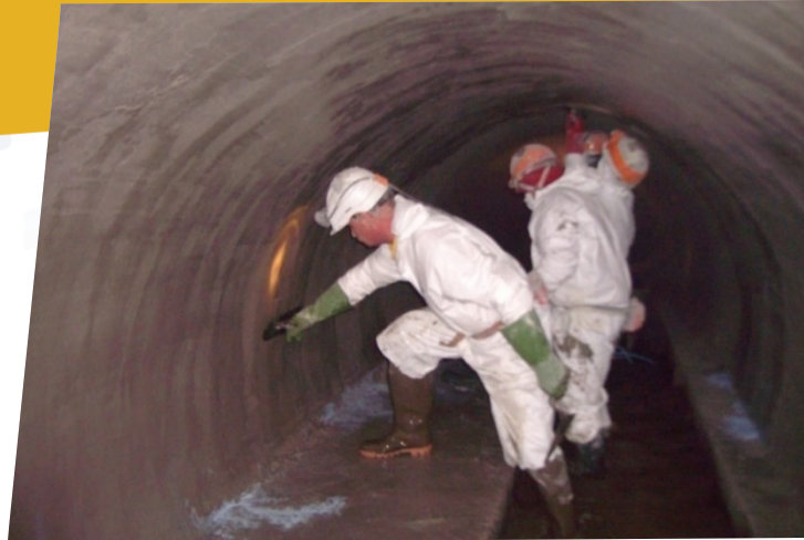
Réhabilitation d'un collecteur-©SERFIM
